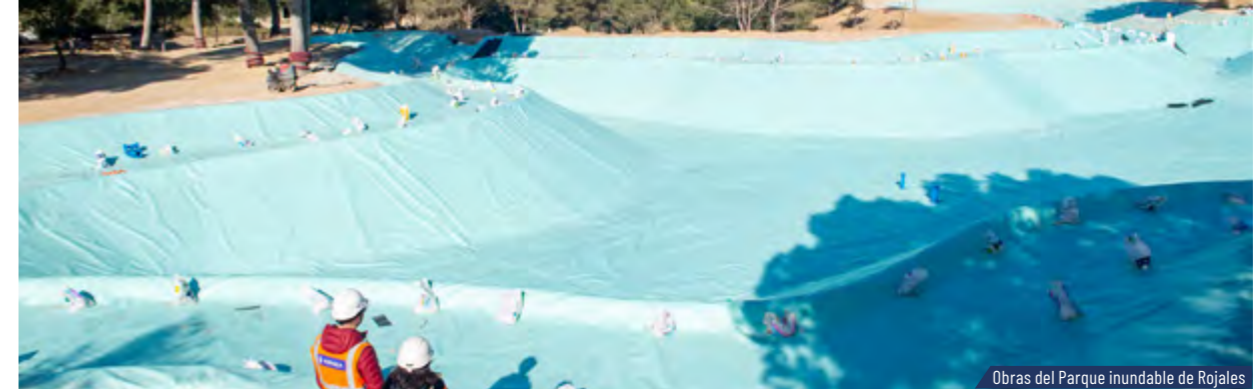
Obras del Parque inundable de Rojales
