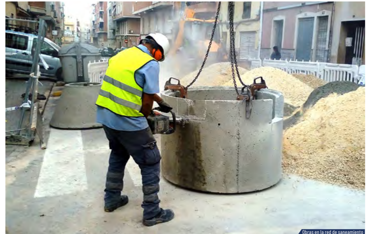
Obras en la red de saneamiento
