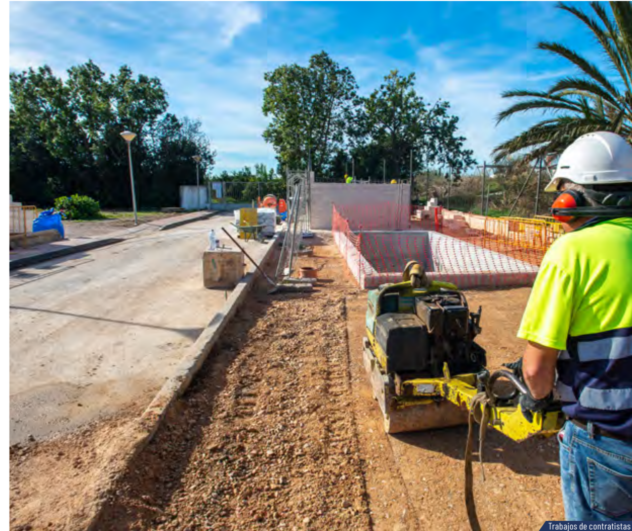
Trabajos de contratistas
