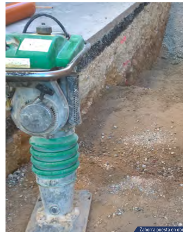
Zahorra puesta en obra
