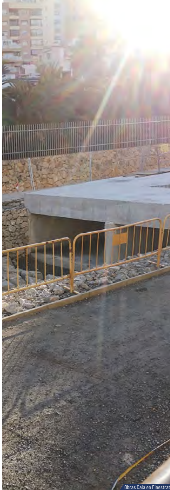
Obras Cala en Finestrat
